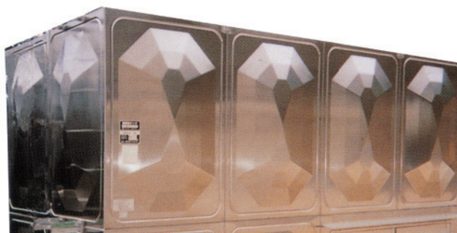
蓄熱槽 (写真はSUS製外装パネル)
